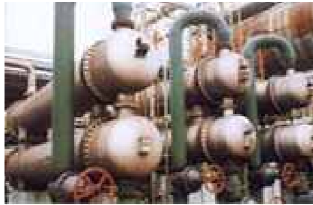
SUS316L换热器 SUS316L heat exchanger
